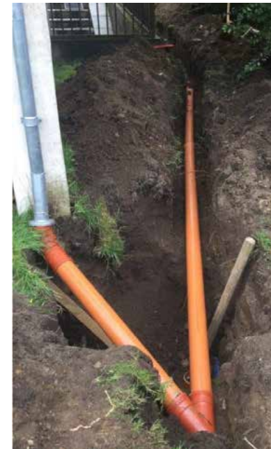
foto: Tjele Entreprenørforetning
